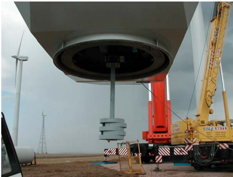
Bild 11: Montage Gondel mit Prototyp-Schwingungsdämpfer in Windkraftanlage
