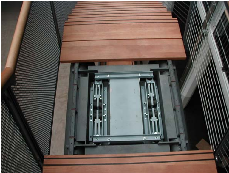
Bild 10: Treppe mit eingebautem Schwingungsdämpfer
