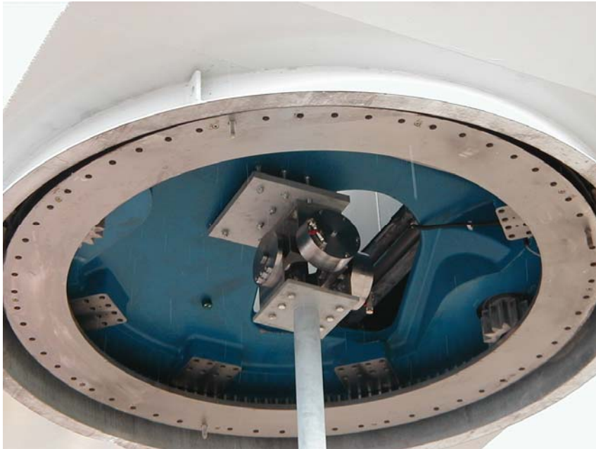
Bild 12: Hydraulischer Dämpfer (Prototyp) für Schwingungsdämpfer erste Turmfrequenz
